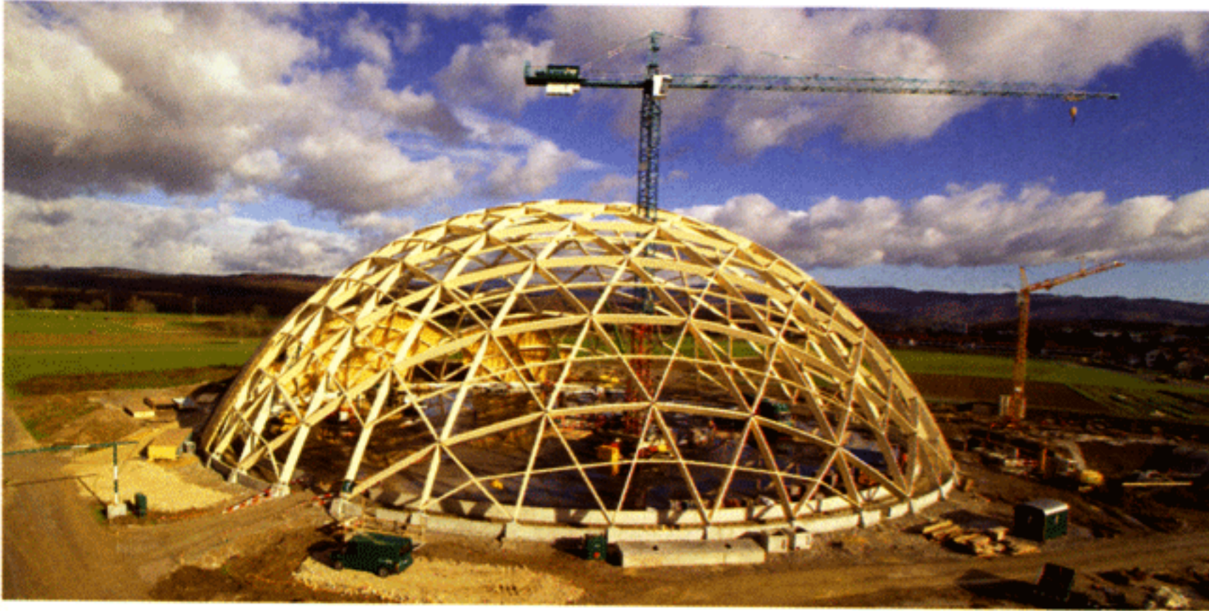
Der grösste Kuppelbau der Schweiz: «Saldome» der Schweizer Rheinsalinen (Aufnahme vom November 2004). Die Spannweite beträgt 93 m und die Höhe 31 m. Das bogenförmige Tragwerk ist aus verleimtem Holz konstruiert. Die Kuppelform entsteht durch ein Netzwerk mit 163 Knotenpunkten. Die Knoten wiederum sind mit 402 zwischen 5 m und 11 m langen Trägerbalken untereinander verbunden (Bild: Beat Zimmermann / Lignum)
