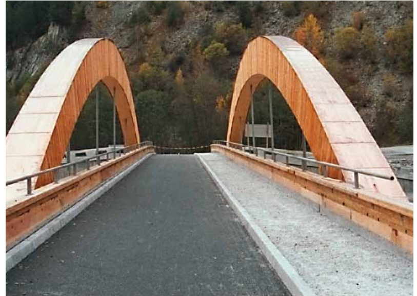
Konstruktiver Holzschutz darf bei Holzbrücken nicht fehlen.
