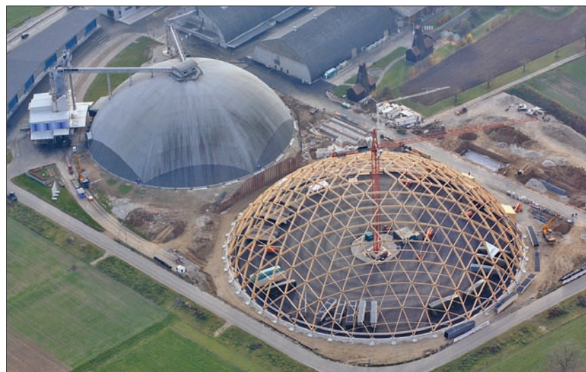
„Saldome 2“ – Das Tragwerkskonzept der zweiten Kuppel entspricht dem der ersten: drei sich durchdringende BSH-Bogensysteme bilden das Tragwerk. In jedem Knoten treffen sechs Bogenteile aufeinander. Foto: Erich Meyer/Rheinsalinen AG
