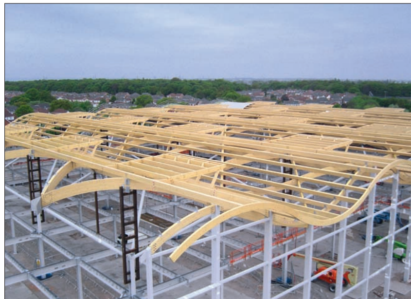
Der neue Marks & Spencer Flagship Store setzt auf Holz – allerdings nur im Dach. Foto: Simons Ltd.
