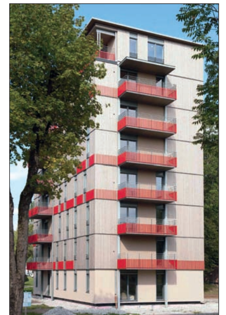
Erster in Deutschland: Achtgeschossiger in Bad Aibling. Foto: Huber & Sohn
