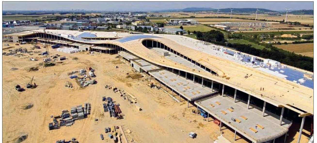
Das etwa 550 m lange Holzdach des „G3 Shopping Resort“ in Gerasdorf überspannt das über acht Fußballfelder große Einkaufsdorado wie eine Welle. Foto: ATP Architekten und Ingenieure; Fotos der Referenten: S. Jacob-Freitag
