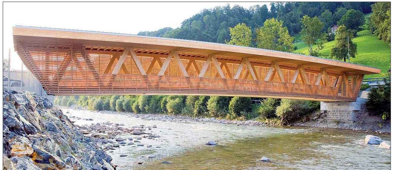
Der Ersatzbau für die alte Enningerbrücke (bei Enningen, Schweiz) ist wie ihre Vorgängerin geschützt ausgeführt: Die einseitige Schwerlastbrücke bilden zwei einfache Fachwerkträger, auf denen ein Flachdach liegt. Eine offene Lamellenschalung und das einseitig auskragende Dach schützt die Brücke vor Bewitterung. Das Bauwerk wurde beim Holzbrückenbau-Preis neben dem Ersten Preis als eine von insgesamt drei Brücken ausgezeichnet. Foto: Pirmin Jung Ing.
