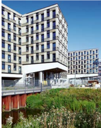
Das Studierendenwohnheim «Woodie» ist ein Holzmodulbau mit sechs Geschossen und 371 Wohnungen für Studierende. Es ist das derzeit grösste Holzhaus Hamburgs .
