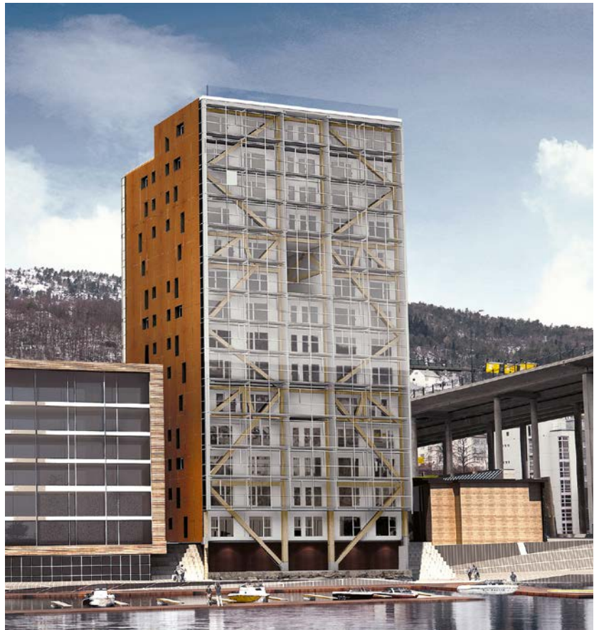
Das derzeit höchste Holzhaus der Welt steht am Fjord von Bergen (Norwegen) und hat den Namen «Treet» (Baum). Das Gebäude ist 51 m hoch, zählt 14 Geschosse und ist aus Raumelementen gebaut.
