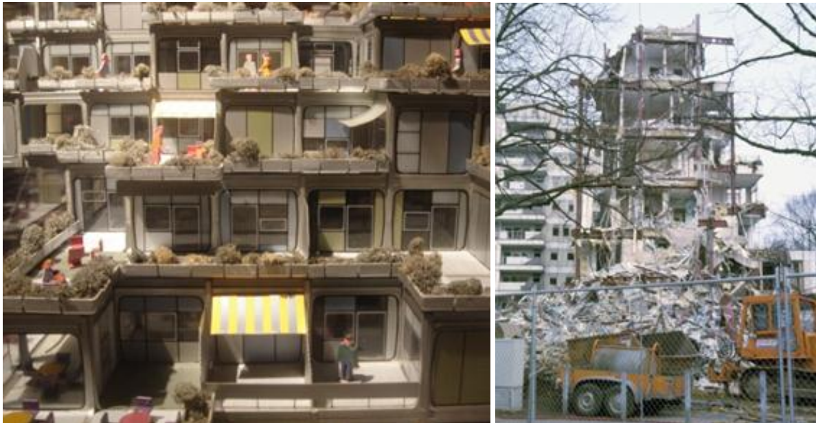
Abb. 3.2-1: Modell der so genannten Meta-Stadt, einem vorgefertigten, demontierbaren und flexiblen Bauelemente-System, das Mitte der 1970er Jahre als Prototyp in der neuen Stadt Wulfen errichtet wurde (links). Wegen unbeherrschbarer technischer Mängel wurde dieser Versuchsneubau der Moderne mit etwa 100 Wohnungen bereits nach etwa zehn Jahren 1986 abgerissen, nachdem sich bereits erhebliche Wohnungs-Leerstände eingestellt hatten (rechts). Quelle: Links eigenes Foto, Foto rechts: E. Krings PBS Architekten Aachen.
