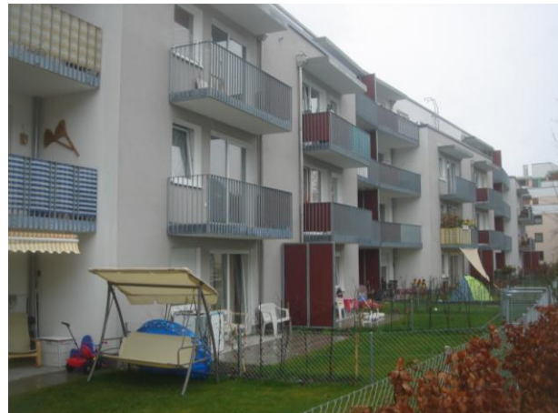
Abbildung 6.1-7: In München wurde Ersatzneubau kombiniert mit Nachverdichtung und Modernisierung realisiert. Quelle: Eigene Abbildung.
