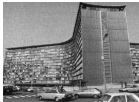
Abbildung 4.6-2: Bericht des Magazins „Spiegel“ von 1995 über die Sanierung des Verwaltungsgebäudes Berlaymont der Europäischen Union in Brüssel. Die in dem Bericht genannten Sanierungskosten von 70 Millionen DM haben sich im Zuge der Baumaßnahmen etwa um das 43-fache erhöht auf 1.500 Millionen Euro. Quelle Text und Foto: Der Spiegel Nr. 30 / 1995, Seite: 109.
