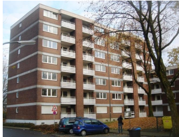
Abbildung 9.3-2: Das Quartier in Bottrop-Eigen umfasste zwei Hochhäuser mit bis zu sieben Geschossen, die abgerissen wurden, sowie bis zu viergeschossige Gebäude gleicher Bauart, von denen weitere abgerissen und durch Neubauten mit altengerechten Konzeptionen ersetzt wurden. Quelle: Eigenes Foto.
