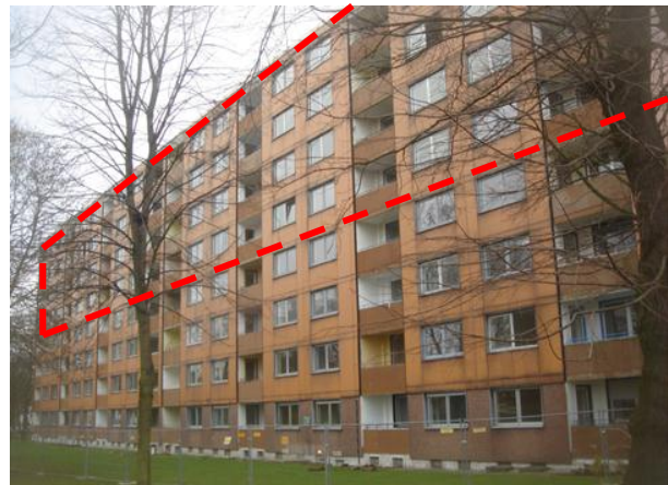
Abbildung 6.1-4: Bei dem Wohnblock in Mülheim wurden die oberen vier Geschosse zurückgebaut. Quelle: Eigene Abbildung.
