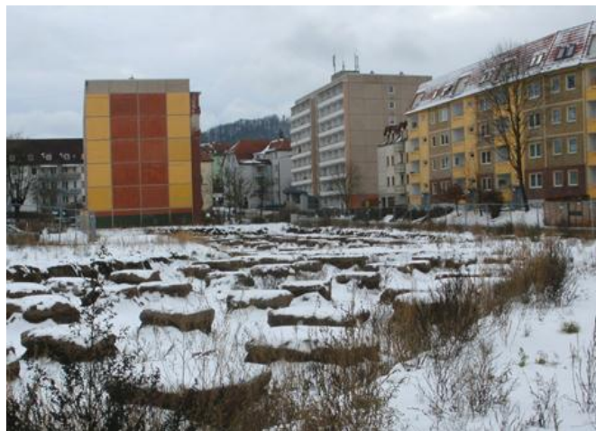
Abbildung 7.1-2: Alte Bestandssubstanz der fünfgeschossigen Plattenbauten im Quartier nahe dem Zentrum von Sondershausen. Oberhalb der im Vordergrund erkennbaren Pfahlgründungsköpfe, die fünf Meter tief bis auf tragfähigen Baugrund reichen, wurden inzwischen mehrere der ehemaligen Plattenbauten abgerissen. Quelle: Eigene Fotos.
