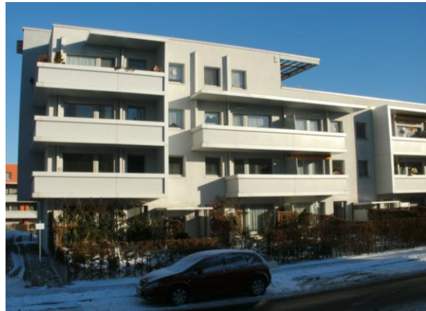
Abbildung 6.1-10: In Dresden erfolgten Rückbau und Modernisierung sowie z.T. der Abriss ganzer Blöcke. Quelle: Eigene Abbildung.
