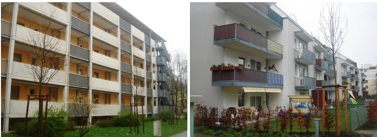
Abbildung 8.3-4: Die neue, barrierefreie Erschließung der Wohnungen erfolgte durch vor das Gebäude gestellte Laubengänge, die vertikal mittels Aufzug erreichbar sind (links). Andere der Gebäude mit schlechterem Zustand wurden abgerissen und durch Neubauten hoher Qualität ersetzt (rechts). Quelle: Eigene Fotos.
