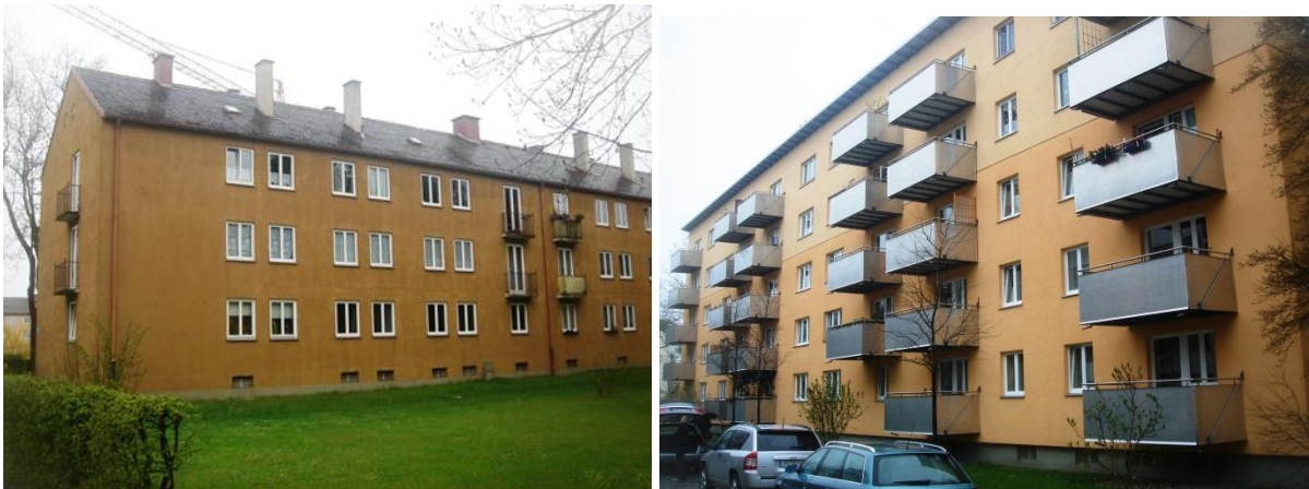
Abbildung 8.3-3: Die in den Jahren 1952 bis 1964 errichteten, dreigeschossigen Gebäude mit kleinen Schichtwohnungen wiesen einfache Qualität auf, ein großzügig begrüntes Wohnumfeld sowie günstige Mieten (links). Eine Umbauvariante für diese Gebäude war die Nachverdichtung durch Aufstockung von zwei Geschossen, die farblich bewusst abgesetzt wurden (rechts). Quelle: Eigene Fotos.
