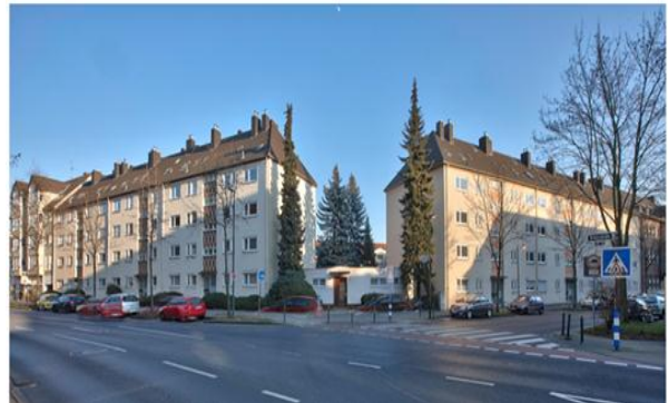
Abbildung 8.2-2: Bestandsgebäude „Die Ecke“ in Düsseldorf vor dem Abriss der Gebäude aus den 1960er Jahren im September 2012. Der Abriss und der Fortgang der Arbeiten wurden kontinuierlich von der WOGEDO in den Medien unter Einbeziehung von Videosequenzen dokumentiert. Bildquelle: WOGEDO.
