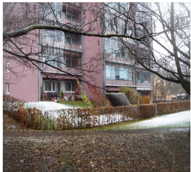
Abbildung 8.1-2: Die sieben Hochhäuser im Piusviertel mit ihren neuen Energiefassaden sind eingebunden in ein parkähnliches Areal, das im Rahmen der Umbaumaßnahmen umfangreich aufwertet wurde. Ein weiteres vergleichbares Beispiel befindet sich im Konradviertel. Quelle: Eigenes Foto.
