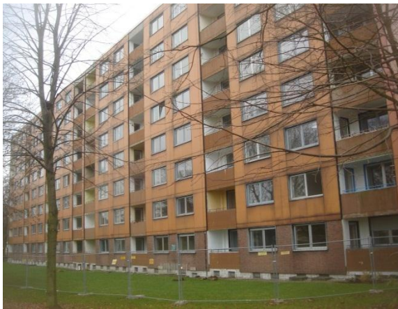
Abbildung 7.3-3: Das Hochhaus in Mülheim-Dümpten dominierte als Solitär seine Umgebung durch seine Länge und Höhe. Barrierefreiheit ließ sich wegen seines ungünstigen Erschließungssystems nicht nachträglich herstellen. Weitere Problempunkte waren die schadstoffbelastete Fassadenbekleidung sowie die Laubengänge, für die eine energetische Optimierung technisch kaum herstellbar war. Quelle: Eigene Fotos.
