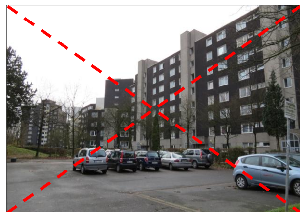
Abbildung 6.1-8: In Münster erfolgten der Abriss des Hochhausblocks und Neubau von Altenwohnungen. Quelle: Eigene Abbildung.
