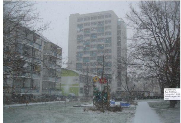
Abbildung 6.1-3: Spreewaldhochhaus in Lübbenau – der Abrissbeschluss wurde widerrufen. Quelle: Eigene Abbildung.
