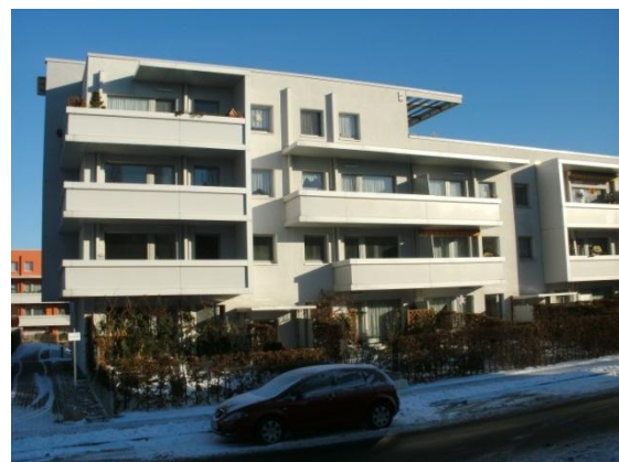
Abbildung 9.2-4: Rückbau um zwei Geschosse und Umbau der restlichen Wohnungen mit relativ hohem Aufwand. Quelle: Eigenes Foto.
