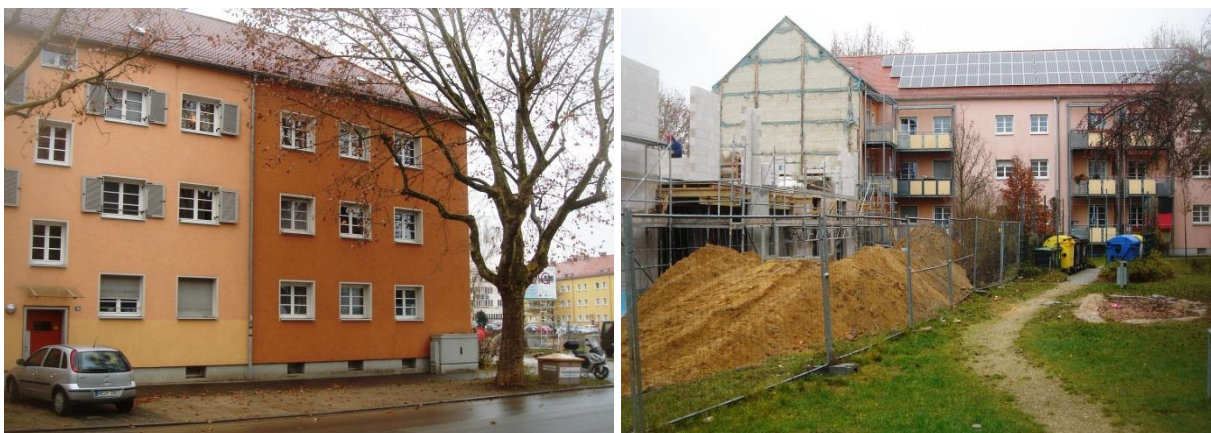
Abbildung 9.1-3: Dreigeschossige Siedlungsgebäude aus den 1920er Jahren, die von der WBG bereits modernisiert wurden, daneben der bereits abgerissene Teil der Siedlung ( linkes Foto). Rückseite des modernisierten Gebäudes mit angebauten Balkonen und Solaranlagen auf dem Satteldach, sowie Anschluss des Neubautraktes nach Abriss des Altbestandes ( rechtes Foto). Quelle: Eigene Fotos.
